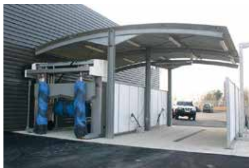
Station de lavage de Clerfond
