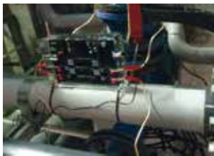
Vulcan S25 installé sur la conduite d'eau principale
